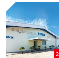
インドネシア・ビンタン工場
