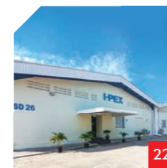
Bintan Plant, Indonesia
