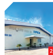
インドネシア・ビンタン工場
