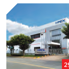
ベトナム・ホーチミン工場
