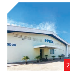
Bintan Plant, Indonesia
