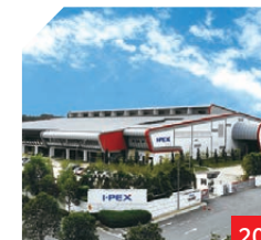
20 マレーシア・ジョホールバル工場
